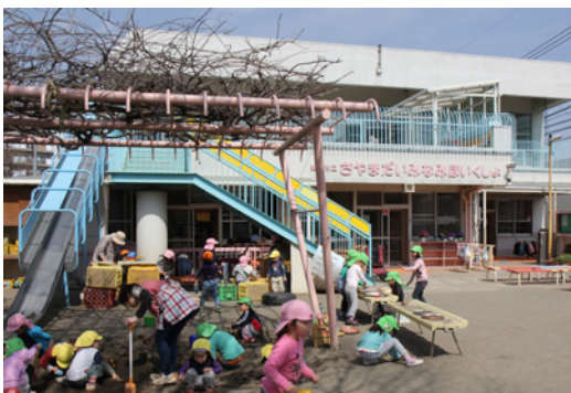
保育環境の質を維持するため、除湿温度保持・耐震改修工事を実施(狭山台南保育所)
