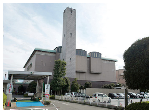
改良工事を実施し、安定的な運営管理と長寿命化を図る(稲荷山環境センター)
