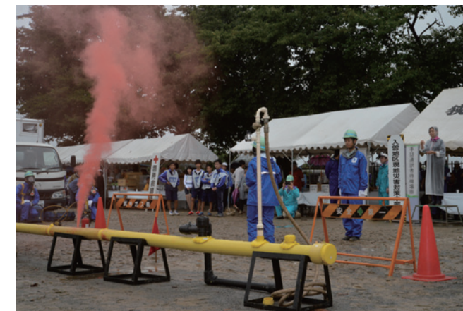
メイン会場では、ガス管の復旧訓練なども行いました
