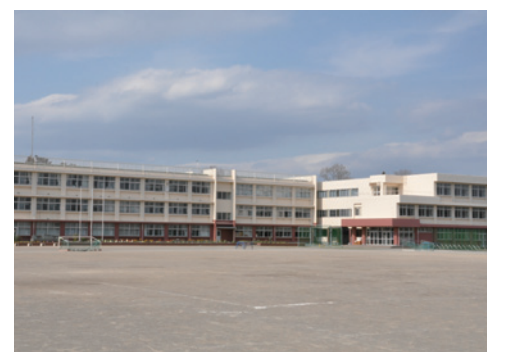
災害発生時に備え、校舎の屋上に太陽光発電設備を設置(狭山台中学校)
