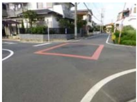
(例)中央にある四角(赤色)は、交差点進入時に注意を促すための標示です
