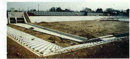
調節池としての機能を併せ持った入曽多目的広場(調節池)を整備中
