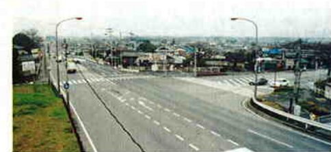
狭山環状有料道路と国道16号との立体交差事業が進行中
