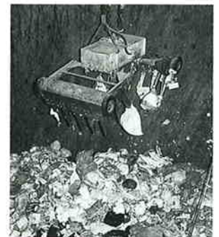
ごみピットの内部 (清掃センター)
