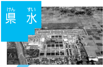
大久保浄水場(埼玉県)
