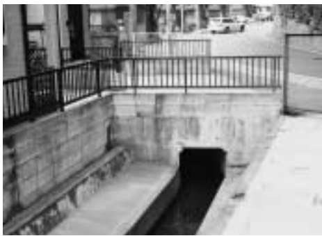
敷地への出入りのために、公共物（水路敷地）の上に通路を設置することを許可されている例
