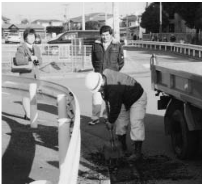
側溝や集水ますの清掃、低木などの立木の伐採、簡易な舗装整備は、直営工事担当の職員10名で行います。
