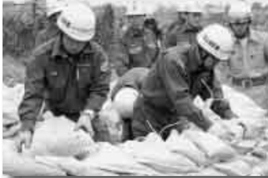
写真の月の輪工法は、堤防の裏側から決壊を防ぐことができます。
