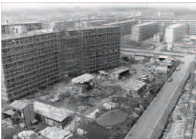
建設が進む狭山台団地(昭和49年)
