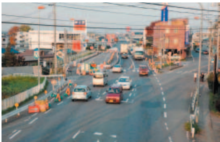
4車線化の工事が着々と進行する国道16号
