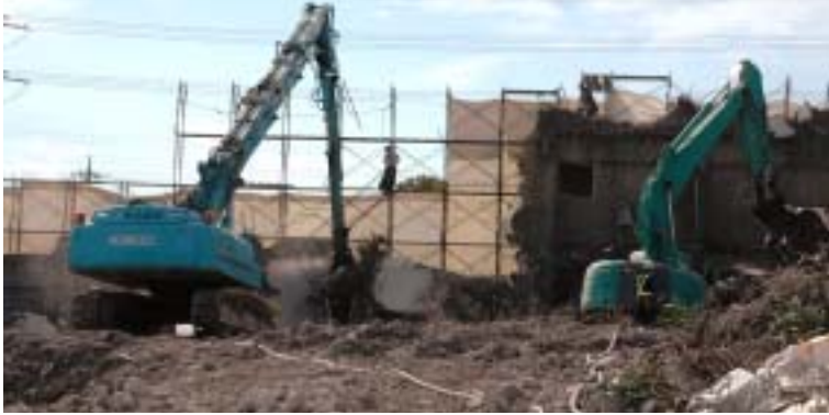
粗大ごみ処理施設とリサイクルセンター、リサイクル工房などの機能を併せ持つ「狭山リサイクルプラザ」の建設に向けて
