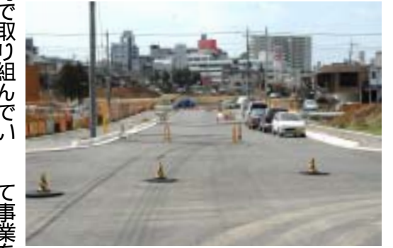
道路整備が進む狭山市駅東口地区
