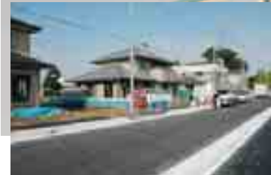
転居される方の住宅の建設も着々と進行
