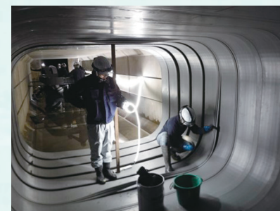
▲耐震化工事の様子(下水道)
