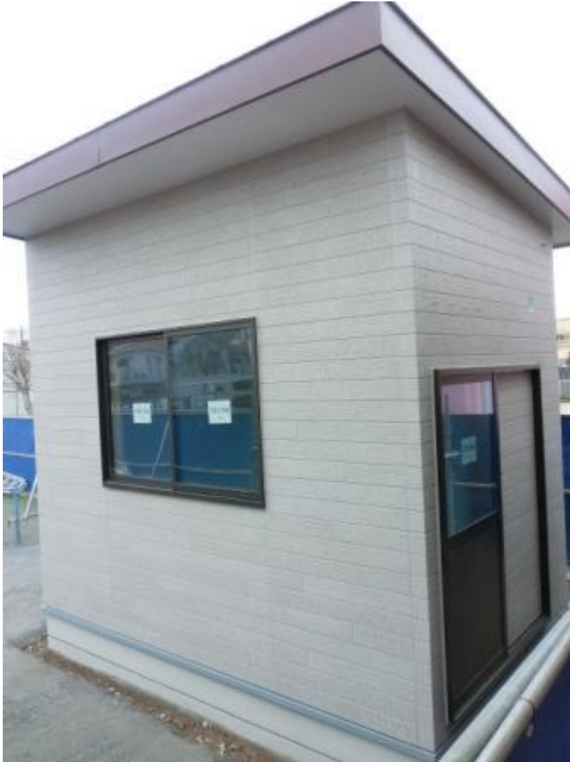
写真：相談室増設 令和8年2月中旬撮影
