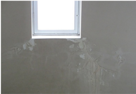
写真1 御狩場小学校
