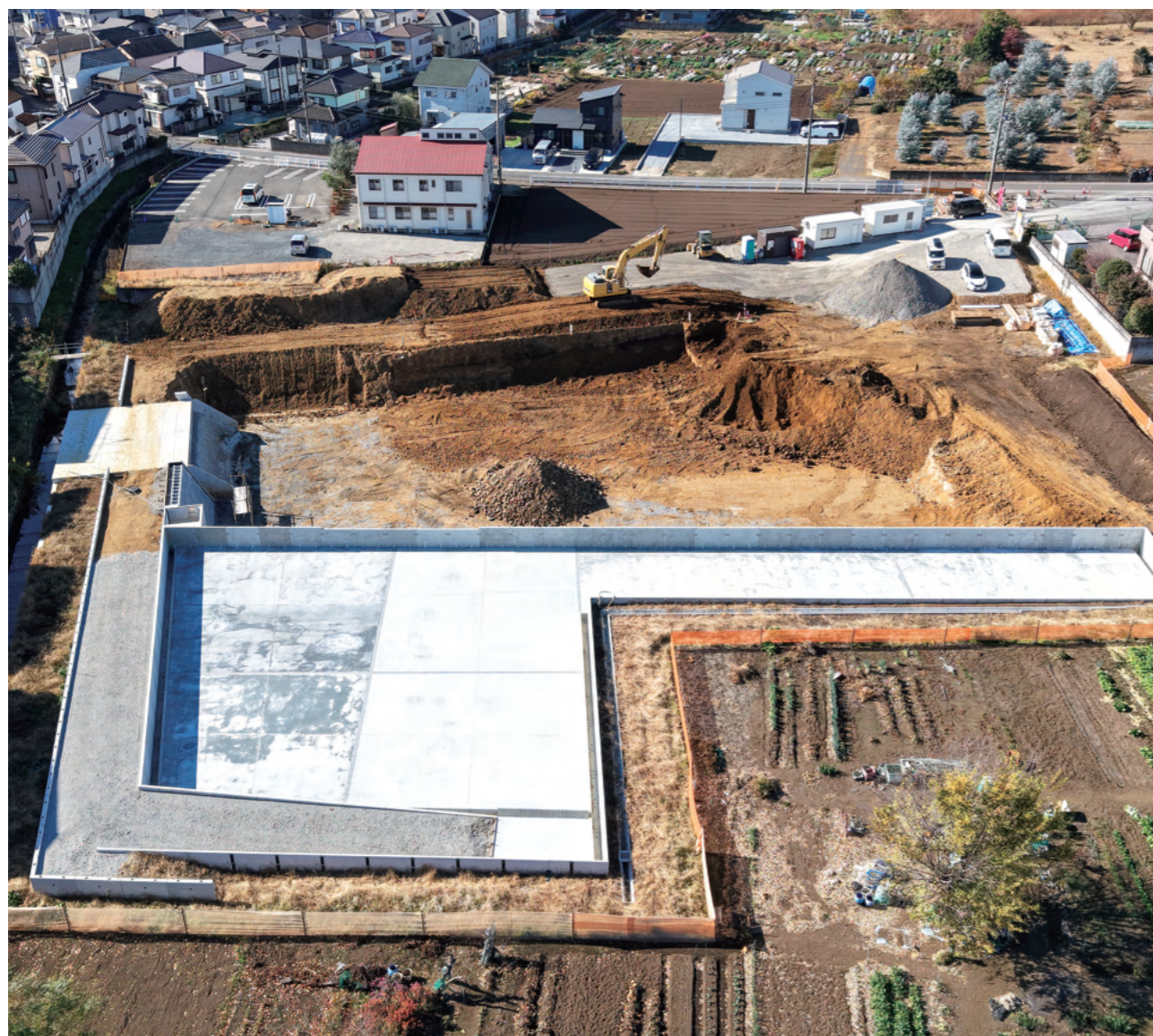
写真：整備中の久保川調節池・調整池
