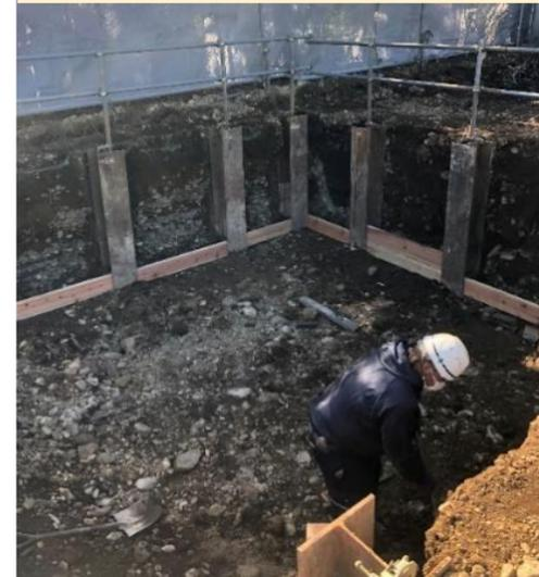
②貯留槽を置くための土台をコンクリートでつくります。
