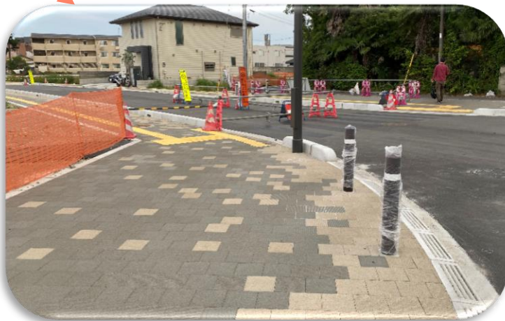
歩道が整備され完成の兆しが見えてきました
