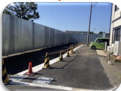
区画道路3号線整備工事
