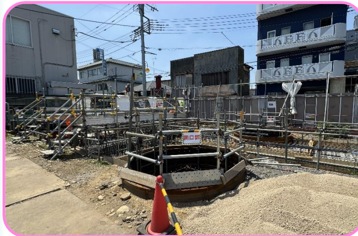
▲東西自由通路の基礎工事が実施されています
