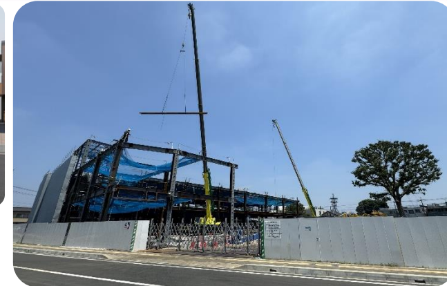
▲店舗の鉄骨が建てられています
