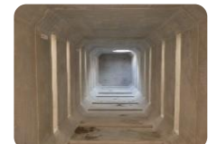
雨水浸透貯留槽の内部
