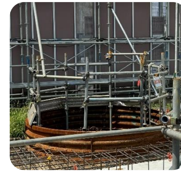
東西自由通路の基礎工事を実施中です
