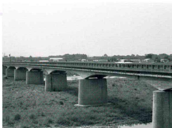
本橋は昭和31年に完成して以来、歩道の新設や右折レーンの取り付けによる拡幅の工事等を経て外観が変わってきました。当初の橋は橋脚にのる桁は湾曲していて優美な姿でしたが、歩道取り付けや拡幅工事で直線の桁を載せたため趣がかわりました。
